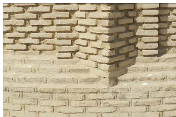
تصویر ۵. اتصال پایه برج به بدنه آن و نحوه آجرچینی پایه و بخش میانی بدنه (عکس از: نویسنده، ۱۳۹۴).
