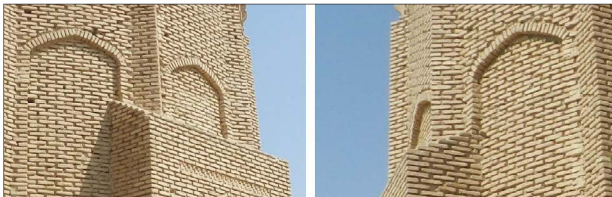
تصویر ۱۵. حجم ورودی و ارتباط آن با طاق نماهای شرق (راست)، بالا و غرب آن (چپ) (عکس از: نویسنده، ۱۳۹۴).
