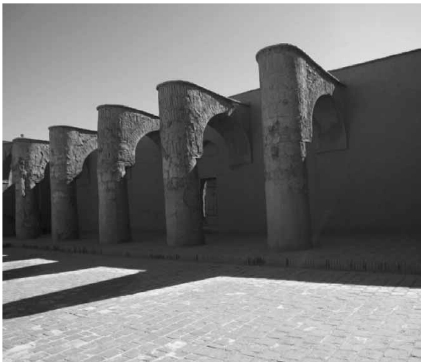
تصویر شماره (۴): رواق ضلع شرقی مسجد تاریخانه
